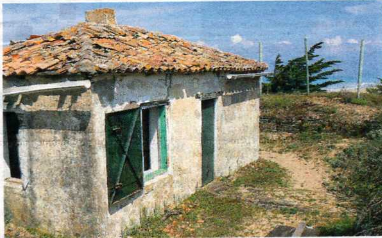
La Cabane des Fontaines avant sa restauration.
