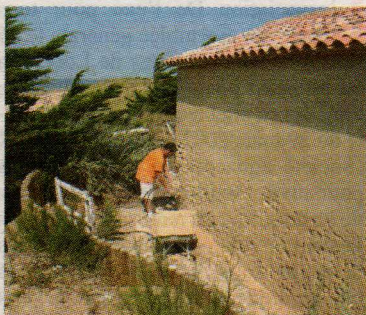
Le crépissage des murs avant la touche finale.
