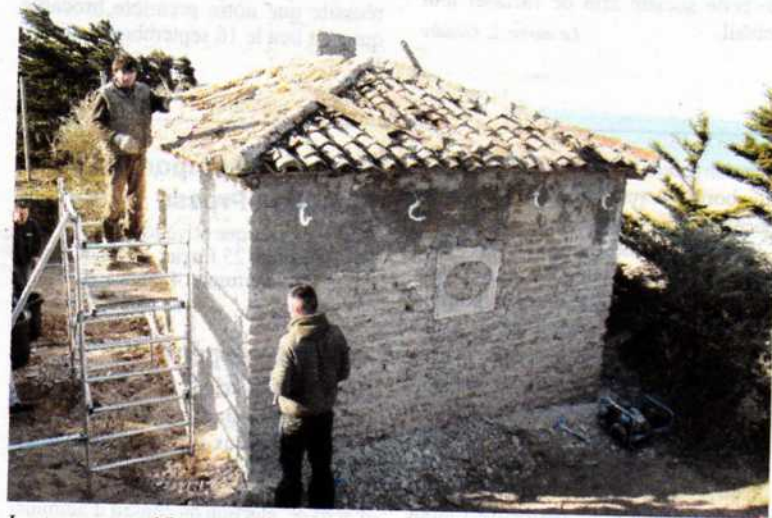
Les travaux ont débuté à la cabane des Fontaines.
