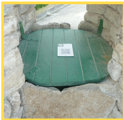
QR code sur le puits de la Tourette
